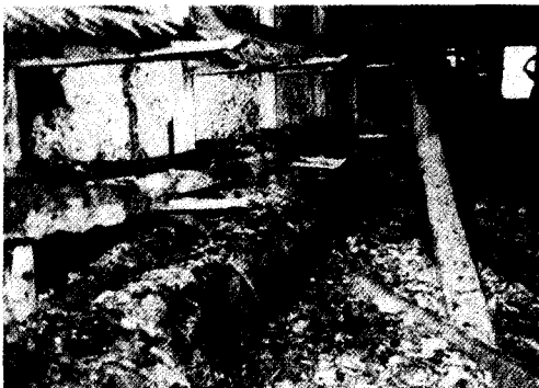
그림 22. 구조체 내부의 난방관 모습
