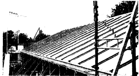
(b) 일체형 집열기가 설치된 후의 전경
