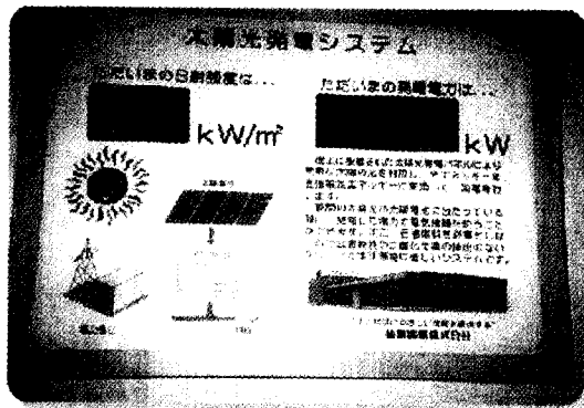
사진 3, 4 태양광 발전 상태 표시
