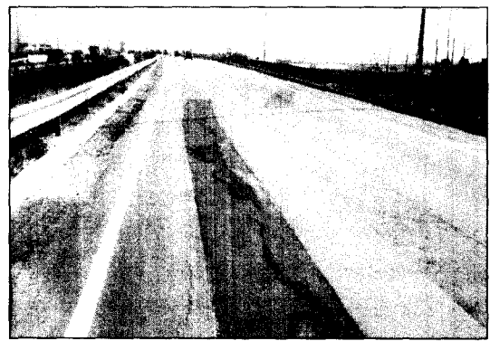
그림 25. 부등침하로 인한 포장면 침하 및 균열
