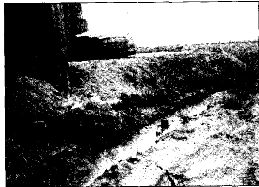
그림 13. SCP 시공시 주변의 용기 및 균열
