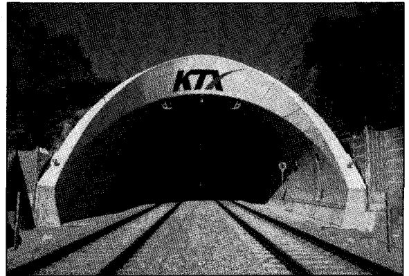
그림 3. 터널개문 전경(Bell Mouse 형)
