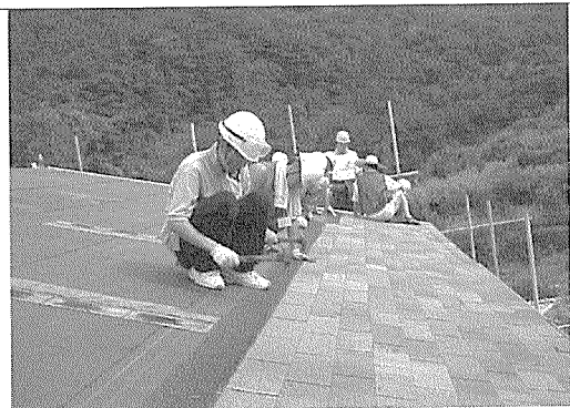
자원봉사자에 의한 지붕공사
