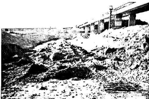
<그림 - 5> 피복석 보강 완료후 전경
