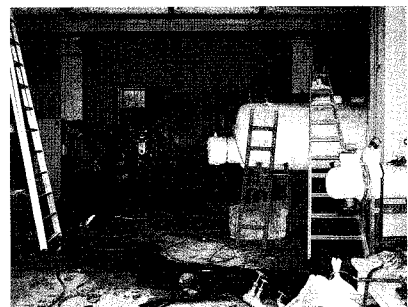
교육부분의 냉난방 개선사업은 부산시민도서관이 처음이다. 총 사업비 13억2천3백만원이 소요되는 이 사업은 매년 1억7천3백만원의 에너지비용을 절약할 수 있을 것으로 보이며 투자비 상환기간은 7.6년이 소요될 예정이다. 시민도서관 모습(맨위)과 노후 시설철거중인 기계실 모습(아래).
