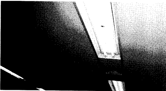
총 900만원이 소요된 이 아파트의 조명공사는 관리사무소와 경비초소, 기계실 등에 설치된 기존 40W 자기식 안정기를 32W 전자식으로 바꾸고, 각종 복도마다 설치된 60W 백열등을 15W 전구식 형광등으로 교체하는 작업이었다.
