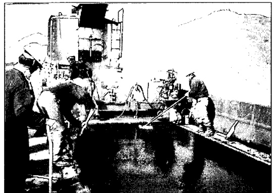
그림. 1, 2 Finisher와 구스아스팔트 포장광경
