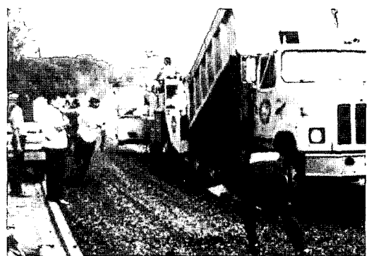
그림 7. Fast Track 시공 모습
