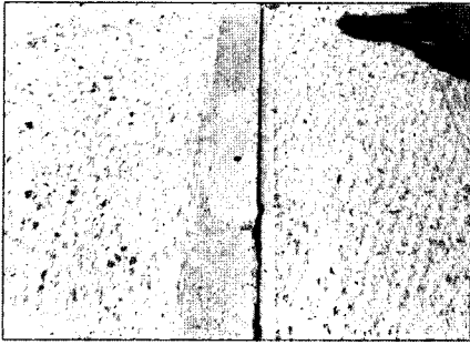
그림 21. 샌드블라스팅 후의 콘크리트 표면
