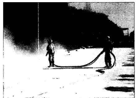
그림 20. 샌드블라스팅을 이용한 표면처리
