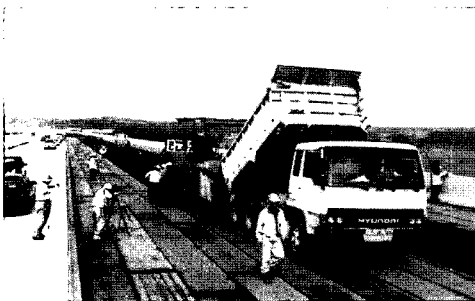
사진 1. 하부 혼합물 층의 시공
