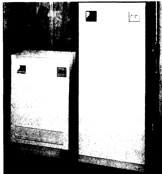
〈그림 2〉 대판가스가 NEXT21에 설치하여 거주 실험에 사용된 연료전지 시스템(좌측이 전지, 우측이 저탕조)
