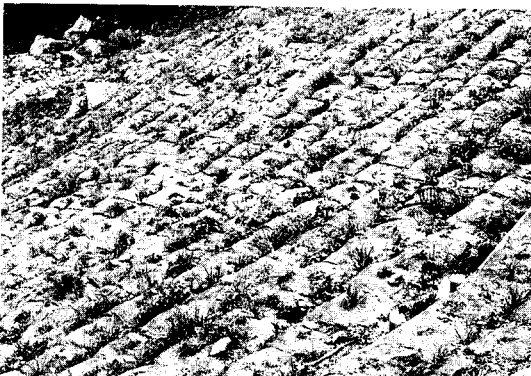
사진 17. 장터목산장 일원의 야생풀포기공법을 사용한 훼손지 복구공사(1999)
