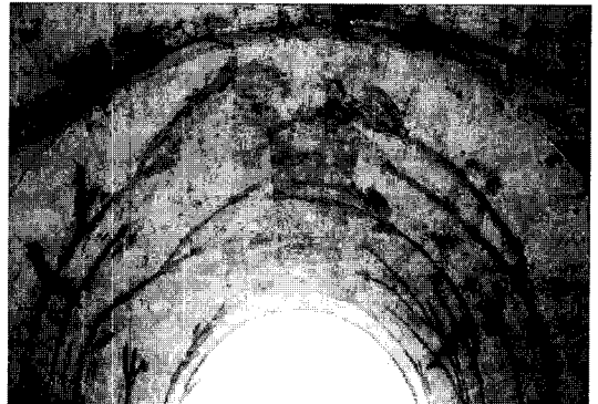
(4) 상부 균열 누수 보수 완료
