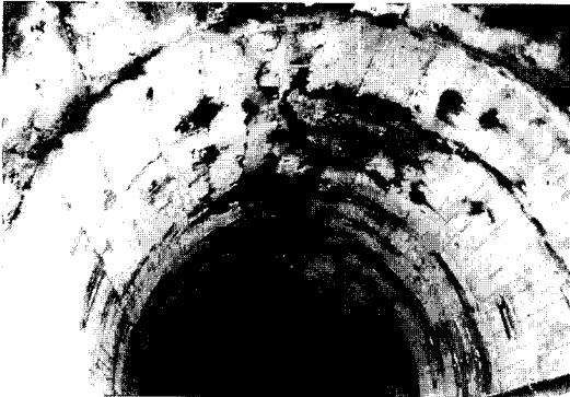
(1) 누수 및 열화 전경
