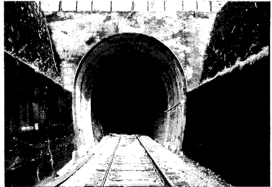
(6) 시공 완료 전경
