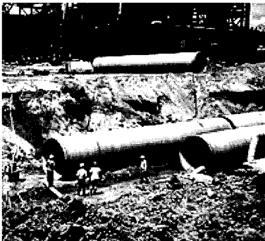
그림 17. 지하에 매설 중인 FRP 수로관
