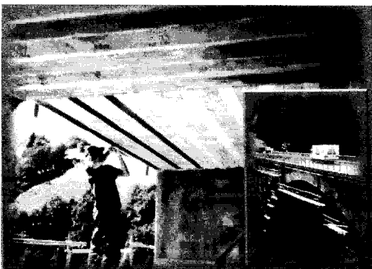
그림 10. 교량 바닥판의 FRP 보강
