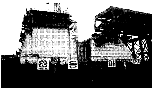
그림 12. 시공 중인 앵커구체(측면)
