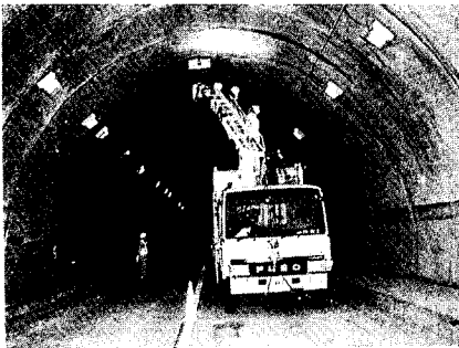
사진 5. 레이더법을 이용한 터널 공동 점검 차
