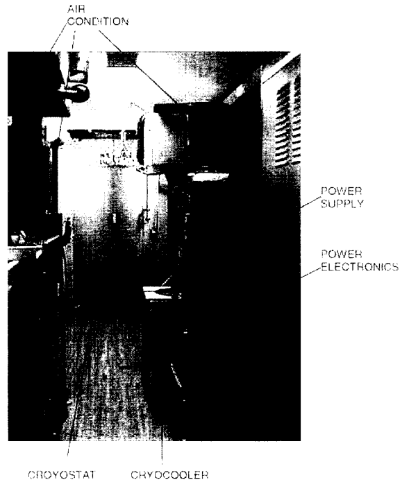
그림 10. 유럽 최초의 상업용 SMES Unit를 탑재한 Trailer 내부
