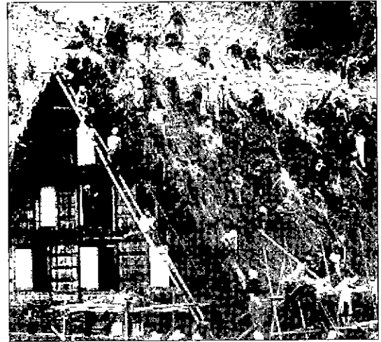
사진 3. 시라카와의 주민참여를 통한 갯소형가옥 지붕잇기
