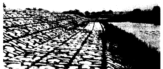
사진 5. 자연석 호안블럭 시공"예"
