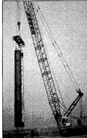
사진 2. 선형 철근망 건입
