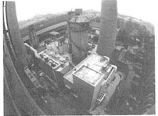
[사진 1] 成都市의 플랜트장치 전경
