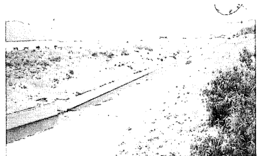
<사진 1> 콘크리트 개거와 사면보호용 사석시공
