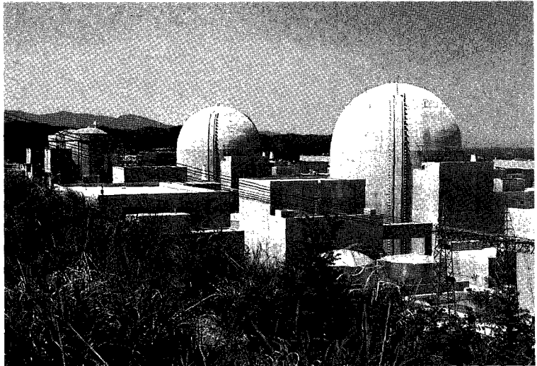
울진 원자력 1~4호기. 전기는 그 특성상 저장이 불가능하여 생산과 소비가 동시에 이루어지기 때문에 피크가 걸리는 여름 한철 오후 두 세 시간의 최대 수요를 위해 막대한 자금을 들여 발전소를 건설하고 있다. 특히 원자력발전소는 기저 부하를 담당하는 대용량 발전소로 하계 전력 수급에 중추적인 역할을 담당하는 만큼 발전소 고장 방지 대책의 수립·시행으로 안정적인 발전소 운영에 심혈을 기울여야 하겠다.
