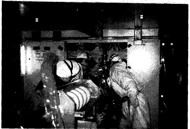
압력관 가터 스프링 위치 교정 작업. 95년부터 수행되고 있는 압력관 가터 스프링 교정 작업은 올해까지 4차에 걸쳐 수행되고 있으며, 2,000년도에 완료될 예정이다.
