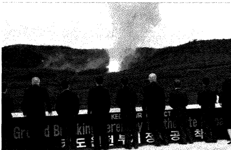
북한 경수로 건설 부지 준비 공사 착공식 발파 장면. 97년 8월 19일 역사적인 부지 준비 공사 착공식이 경수로 부지인 함경남도 신포시 인근 금호 지구에서 거행되었다. 당초 1년 계획으로 추진되었던 공사는 재원 분담 협상 지연 및 주계약 체결 일정 등을 고려하여 3차례에 걸쳐 연장되었다.
