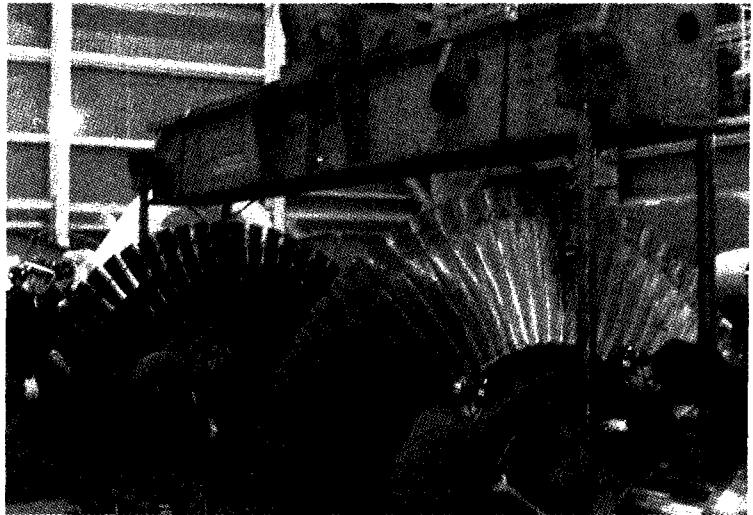
저압 터빈 로터 인양 작업. 고리 4호기는 96년 국내 최초로 잠전된 장주기(18개월) 노심으로 OCTF를 달성한 데 힘입어 '허먼 펀드'는 자신감을 얻었고, 그 결과 97년에 이어 올해에도 OCTF를 달성하게 되어 3주기 연속 OCTF를 달성하는 성과를 거둘 수 있었다.
