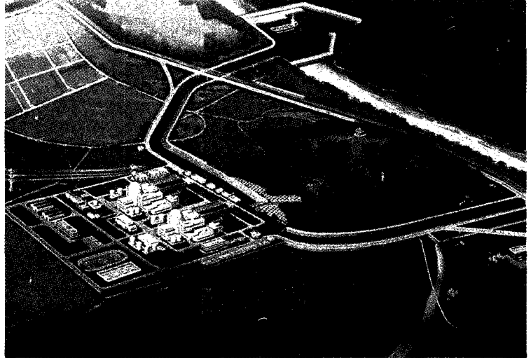
KEDO 원전 건설 조감도. 금년중에 이루어질 주요 공사는 원자로 설비와 터빈 발전기의 초기 설계 및 제작 착수, 핵연료의 초기 노심 설계 착수, 플랜트 종합 설계 착수, 그리고 시공 분야에서는 부지 정지, 취수 방파제 및 물량장 축조 공사, 도로·기능공 숙소 등의 기반 시설 공사 등이다.
