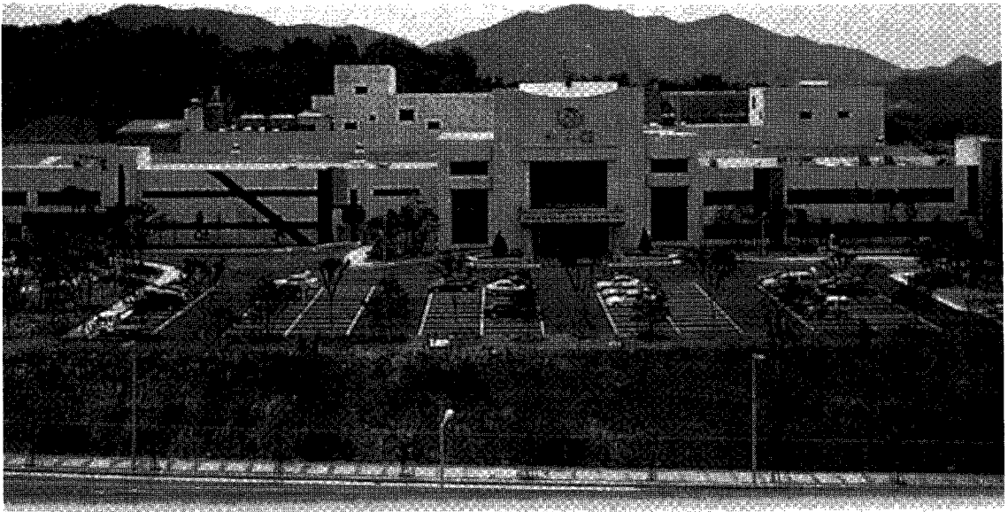
△ 목우촌 계육가공공장 전경
