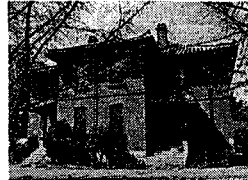
그림 7 동산성경학교(1914) 대구 계산성당 산하의 교육시설로 벽돌조의 건물에 한식지붕을 얹었다. 단순한 평면을로 처리하여 매스감을 더하였고 그 위에 무게감이 있는 기와지붕을 얹어 안정적인 비례감을 꾀하고 있다.
