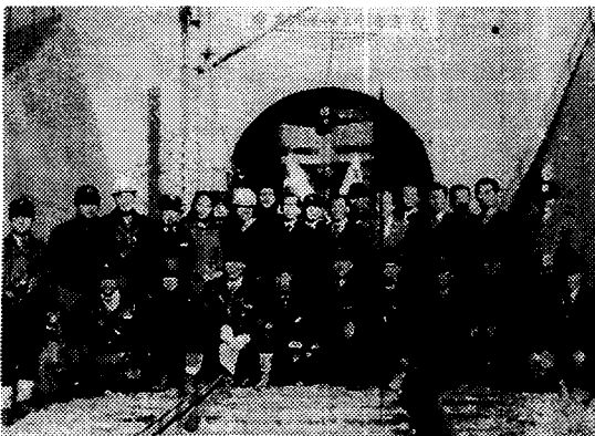
[터널 개통 후 현장 종사원들과 합동 기념 촬영]
