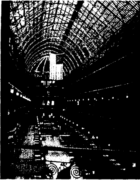
그림 1 아트리움 대공간의 내부전경
