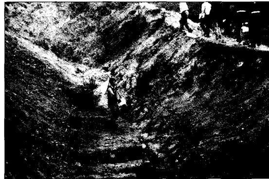
사진 3. 지반함몰과 인장균열의 모습
