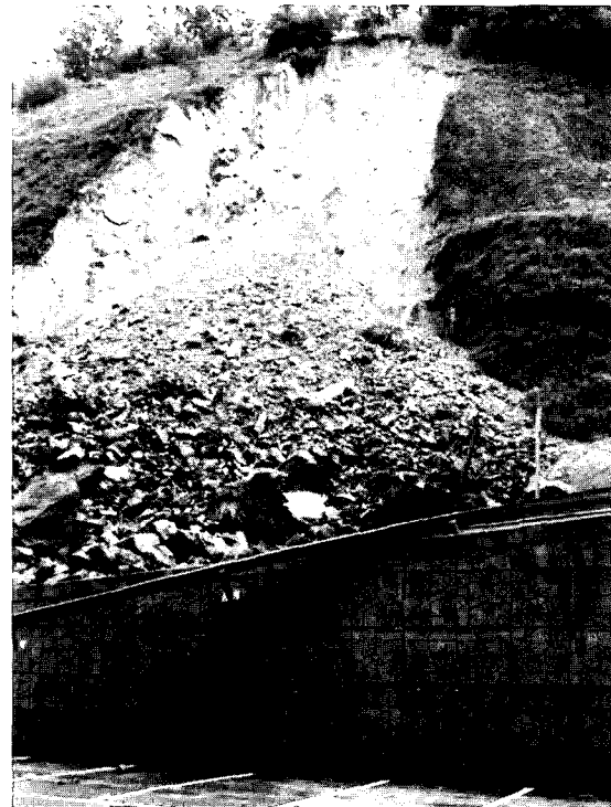
그림 6.1.1. 안동시내 아파트 주변 도로절개사면에서의 붕괴
