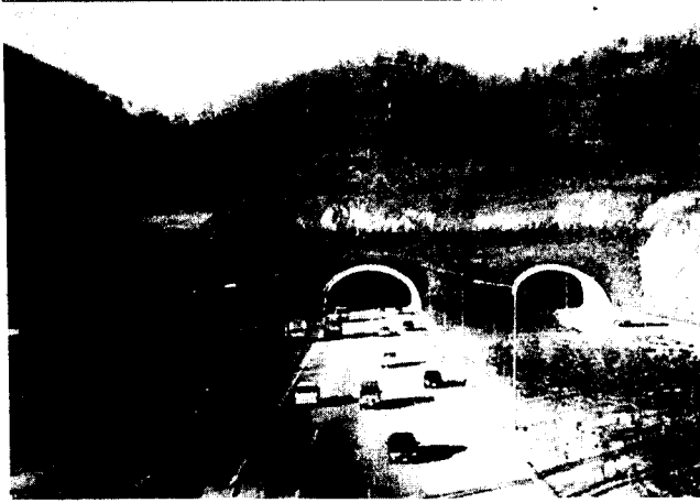
사진 1 청계터널 입구부 전경
