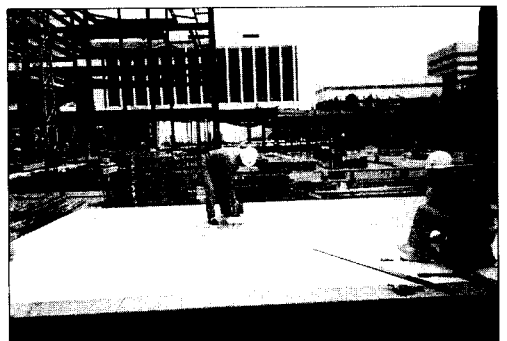
사진 4 Form facing material 부착
