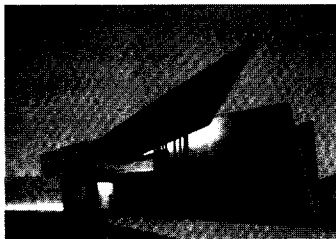
<그림 9> 자하 하디드의 비트라 공장 소방서 건물
