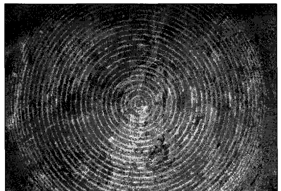
사진 1. TBM Cutter 및 굴착형상.
