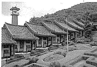
화랑의 집 숙사부분 - 점승적 효과가 살아나 보인다
