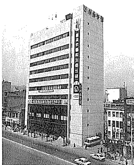
서울특별시 농업협동조합(서울 종로1가에 위치해 있으며 지상10층, 지하2층 연면적 5,540㎡ 규모로 건축됐다.)
