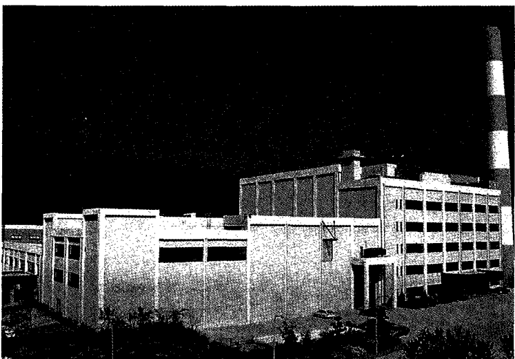
하나로 전경. 왼쪽이 동위원소 건물, 가운데가 조사제 시험 설비 건물, 오른쪽이 원자로 건물이다.
