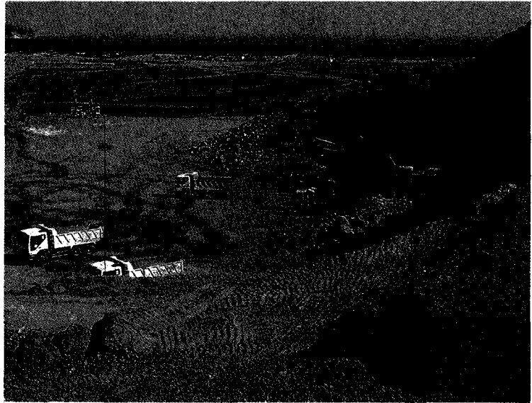
북한 원전 초기 부지 준비 공사 모습. 이번 공사는 작년 8월 착공 이후 연인원 8백여명이 방북하였고, 여객선·화물선·해양조사선 등 우리측 선박이 19회 왕래하였으며, 사업 수행을 위해 컨테이너·중장비·차량·생활용품·공사용 자재 등 약 3만 4천톤의 물자가 현지로 투입되었다.
