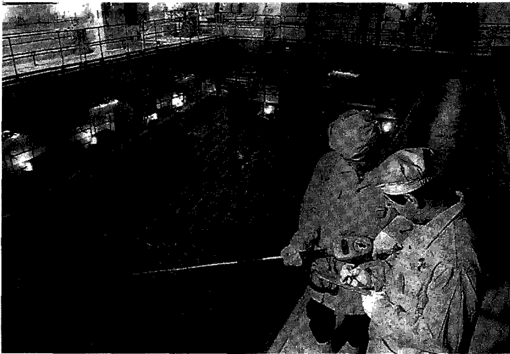
사용후 연료 저장조. 사용후 연료 저장 능력을 확보하기 위하여 경수로 원전은 인근 호기간 공동 저장과 함께 기존의 저장대를 고밀도 저장대로 교체하거나 사용후 연료 저장조의 여유 공간에 고밀도 저장대를 추가로 설치하였으며, 중수로 원전에서는 콘크리트 사일로형의 건식 저장소를 건설하고 있다.
