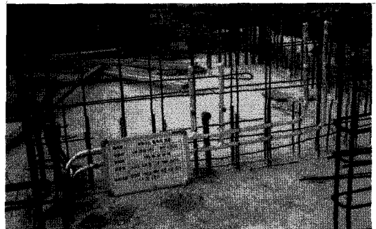
화장실 배관공법개선 (FPE-FAB급수/급탕배관 매립공법)
