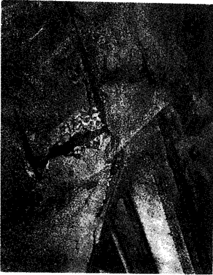
〈그림-3〉 염해로 콘크리트 일부가 떨어져나가 철근이 노출돼 있다.
