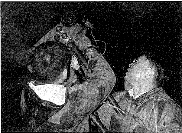
▲ 포항도수터널 안전진단작업중인 조철현박사. (GPR : Ground Penetrating Radar 탐사 장면)
