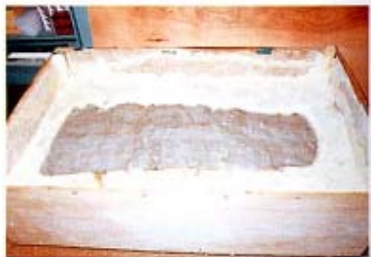
Photo 48. 배면 강화 작업(FRP)
