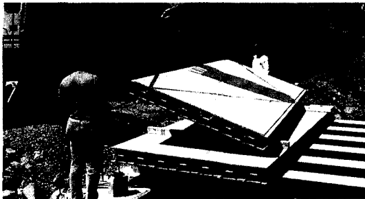
<그림 3> 복합재로 제작(성형)된 교량상판의 설치장면 - 상판의 자중이 불과 22 lb/ft 2 (약 107kg/m 2 )
